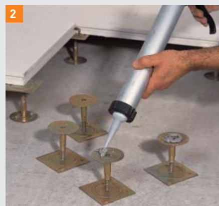
2 Ljepilo na potpornje (unutarnja strana potpornja)
