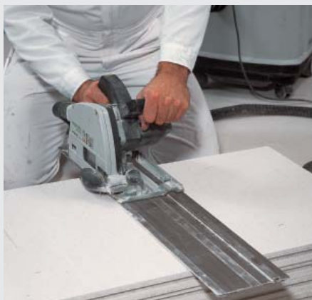
Rezanje pilom s listovima od tvrdog metala i napravom za odsisavanje prašine
