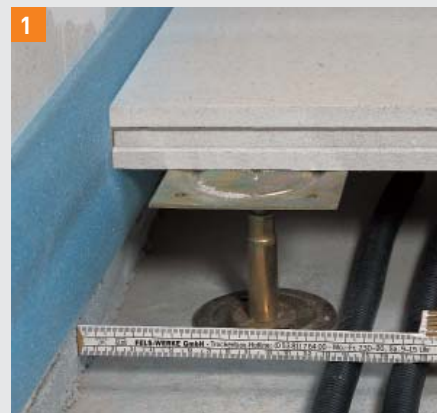
1 Najmanji razmak instalacija premaprema zidu je 110 mm za dodatni rubni potporanj
