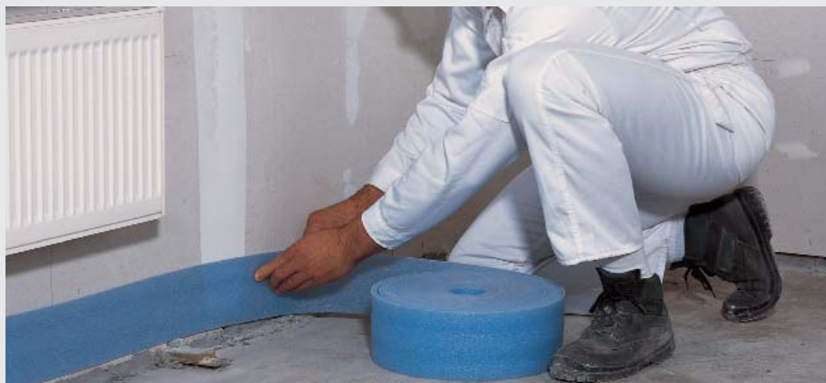
Samoljepljive rubne izolacijekse trake (minimalna visina = element povišenog poda + podna obloga)
