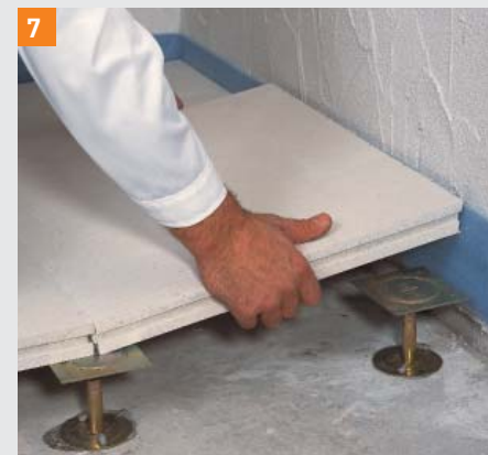
7 Odrezana ploča u području zida s dodatnim-MAXifloor nosivom nožicom
