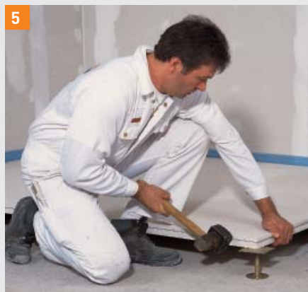
5 spajanje elementa povišenog poda
