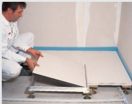
Polaganje MAXifloor Revizijskog poklopca
