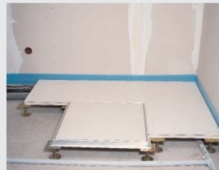
Montirani revizijski poklopci s dodatnim nosivim nožicama
